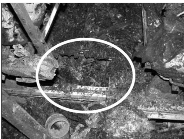
Bild 3.2: Durchbrand in den Innenraum
